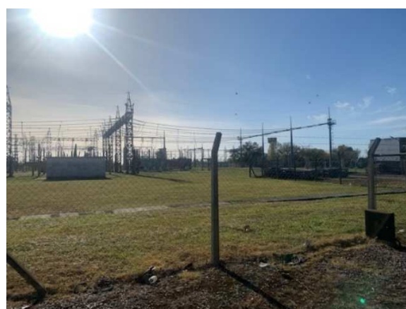
Foto 4: Vista del mismo sector observado en foto 3, pero visualizando desde unos metros al NO del punto de toma de la foto anterior. Se observa el sector de playa de 220 kV de Edesur donde se ejecutará la obra de los campos 22 y 23 (AO)
