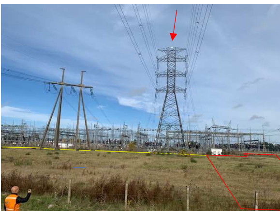
Foto 17. Tomada desde la calle de acceso a GENELBA, en un punto lateral al área de la obra de los bancos de capacitores que se observa en líneas rojas. Se indica la torre que se fue tomada como referencia en las fotos 15 y 16. En amarillo la traza de la LATDT subterránea en 220 kV que se localizará entre la torre señalada y el cerco perimetral de la playa contigua.
