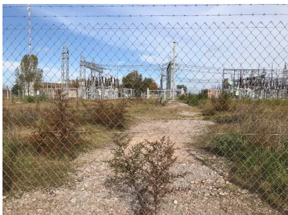
Foto 7. Tomada sobre el cerco perimetral del predio de la ET EZEIZA, al NE del área operativa de la obra Lado Edesur. La foto está tomada sobre la banquina de la calle pública de acceso a la Central Termoeléctrica Genelba. En este sector se abrirá el portón de ingreso del Contratista al sector de la obra Lado Edesur.
