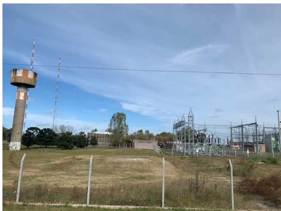
Foto 9. Observando desde el NE de la ET EZEIZA, sobre el perímetro de la misma, en una posición cercana a la de las fotos 7 y 8; se visualiza el Área Operativa (AO) y de Influencia Directa de la obra Lado Edesur. En el centro de la foto se visualiza el Helipuerto
