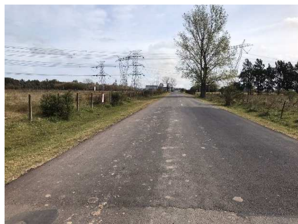
Foto 22. Observando desde el punto de la foto anterior, pero en sentido opuesto, se visualiza la calle de concreto asfáltico que lleva a la Central GENELBA. En línea con el cerco perimetral, y entre este y la calle, se advierte la presencia de una zanja de evacuación de pluviales que se intervendrá en el marco de la obra, pues se debe ejecutar un acceso con alcantarilla de hormigón para la playa de los capacitores. El escurrimiento será hacia Ruta Nacional Nº 3.
