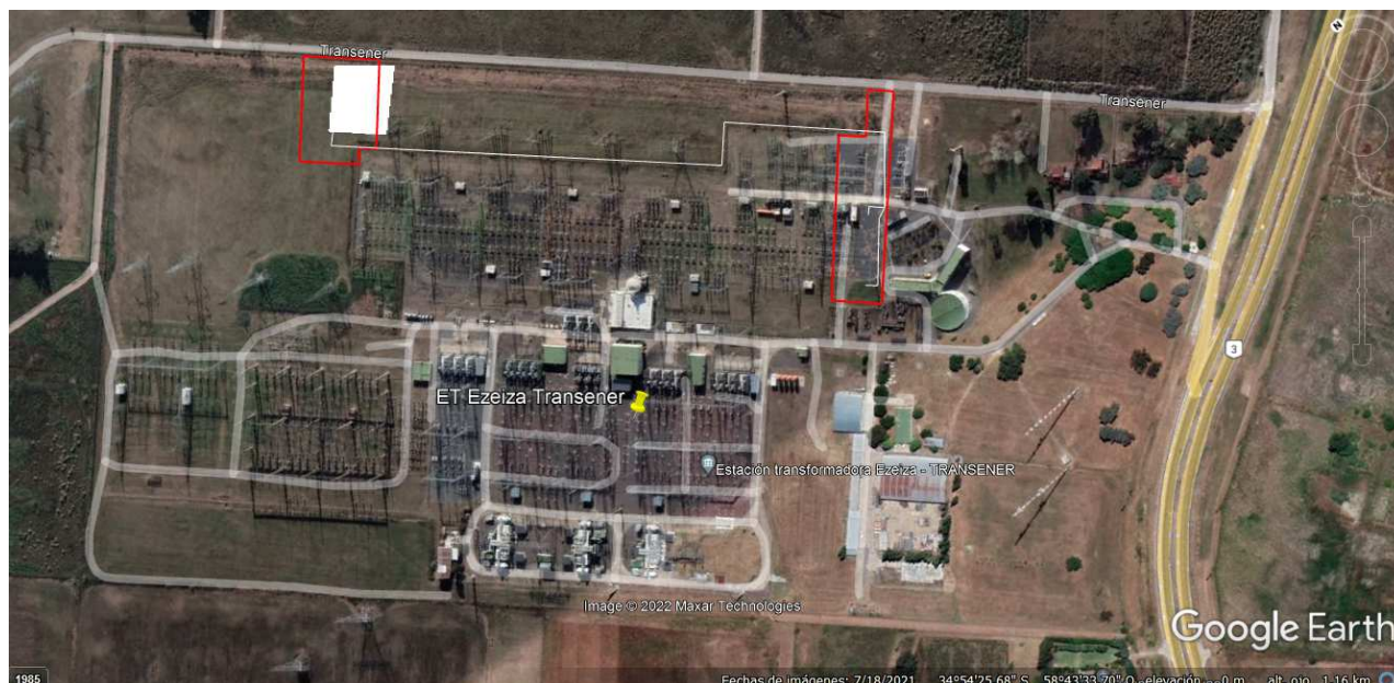
Figura 3.44. Vista de la ET Ezeiza y de los sectores donde se realizará el nuevo proyecto. También se verifica el camino perimetral por el que transita el personal de Transener. Fuente: Google Earth
