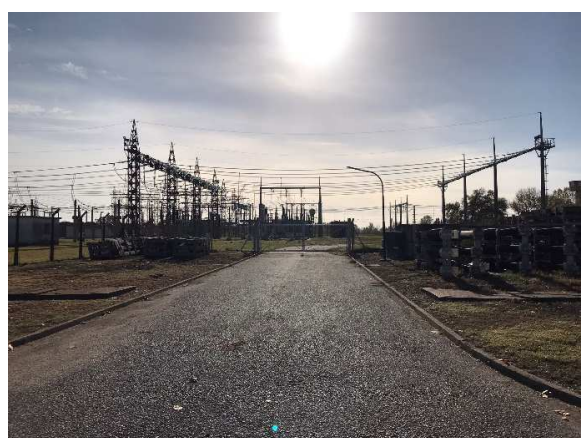
Foto 3: Vista desde un punto, sobre un acceso pavimentado, al SO del AO de la obra Lado Edesur. Tomada desde un punto ubicado en una calle interna de la ET EZEIZA, se visualiza sobre la derecha el pódium de fotos 1 y 2. Casi en la línea de este acceso, sobre la izquierda y a pocos metros dentro del predio, se construirá la Caseta K12 de Edesur.
