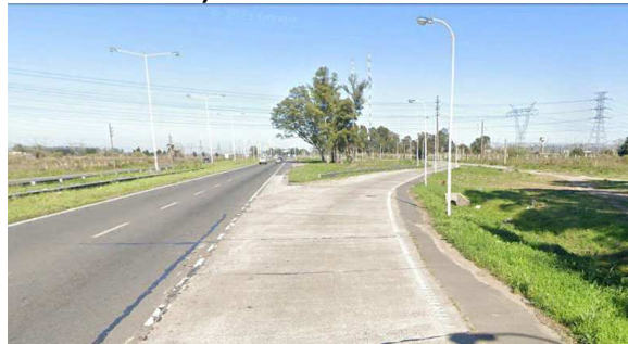
Imagen 2: Ingresando a la dársena señalada en la imagen anterior, se advierte pavimento de hormigón en buenas condiciones, así como la disponibilidad de postes de alumbrado público que siguen la línea del acceso.
