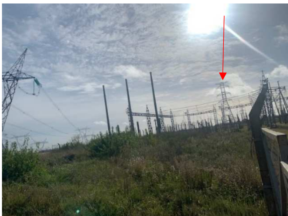
Foto 15. Visualizando desde el cerco perimetral de fotos 13 y 14, observando hacia el área operativa de la obra Lado Transener. Se señala la torre de la doble terna de EZEIZA ZAPPALORTO 1 y 2 de 220 kV, que quedará al SSE del área de la obra de los Bancos de Capacitores K1/K2 a ejecutar.
