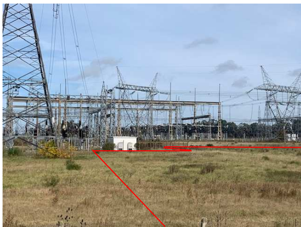
Foto 19. Una toma con zoom desde la calle que lleva a Genelba, permite observar un sector del área operativa de la obra de los bancos de capacitores Lado Transener. Se observa un terreno despejado, nivelado y cubierto con vegetación herbácea. En línea de color rojo se señala parte del predio que aprox. cubrirá la playa del Lado Transener.
