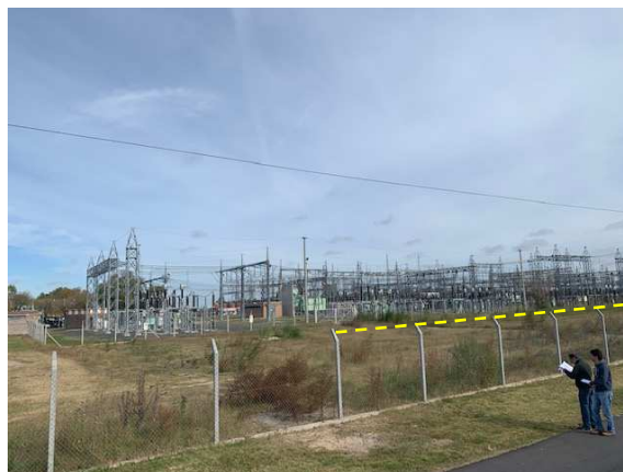
Foto 10. Tomada desde el mismo punto de la foto 9, visualizando hacia el Oeste, se observa el AO de la obra; se observa la franja de terreno, paralela al cerco perimetral existente, por donde se ejecutará la obra de las dos LAT 220 kV subterráneas – se indica con línea amarilla- de interconexión con la playa del Banco de Capacitores (sector de obra Lado Transener).
