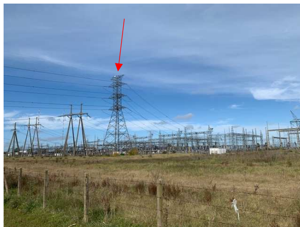
Foto 20. Tomada desde una posición – sobre la calle de acceso a GENELBA – unos metros más al NO de la foto anterior (hacia Genelba). Se aprecia gran parte del predio a intervenir con la obra de los bancos de capacitores shunt. Asimismo, sobre este sector – actualmente despejado de elementos y equipos electromecánicos - se localizará el obrador principal.
