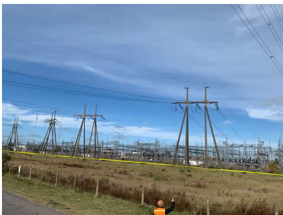
Foto 18. Tomada desde el punto de la foto anterior, girando unos grados hacia el Sur (la izquierda). Se visualizan los soportes de hormigón de las ternas de 220 kV EZEIZA CASANOVA 1 y 2 y EZEIZA PI.TRANSRADIO 1 y 2. En amarillo la traza de las dos LAT subterráneas de interconexión entre la obra Lado Transener y Lado Edesur en 220 kV y FO.
