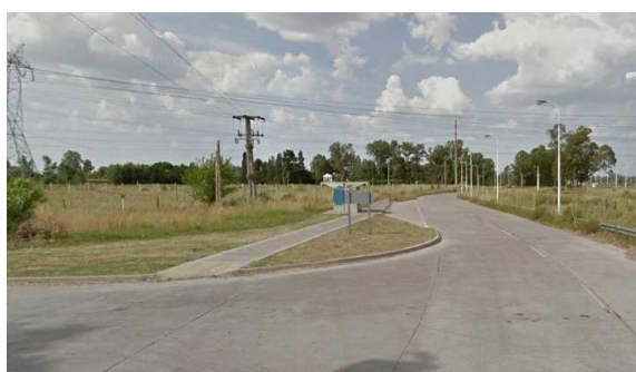
Imagen 8: Tomada a la altura de la calle de acceso a Genelba, observando hacia el Norte. Se visualizan la parada de colectivos, y la vereda que continúa hasta la entrada principal a la ET EZEIZA, localizada a unos 150 metros al Sur de este punto (puede observarse en la imagen anterior).
