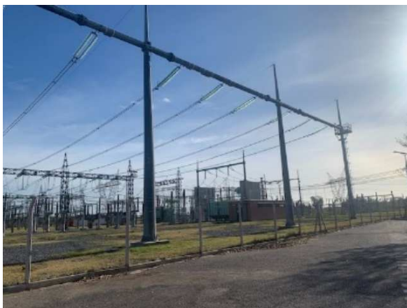
Foto 1: En primer plano, pódium en el área de obra de EDESUR. Ante la imposibilidad – por cuestiones de seguridad – de ingresar a las zonas donde se ejecutará la obra (Área Operativa de la obra: AO), puesto que son “zonas activas” de la ET EZEIZA, se presentan fotos – de los predios de las áreas señaladas – tomadas sobre el perímetro de éstas.
