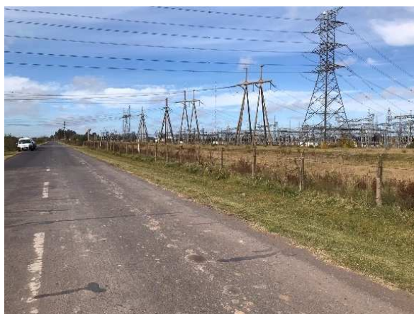
Foto 21. Tomada en inmediaciones del punto anterior, frente al predio de la obra de los bancos de capacitores Lado Transener. Observando en sentido SE se visualiza la calle de acceso a GENELBA; esta calle será también el acceso al área operativa – de ejecución - de la obra. Sobre este sector se ejecutará el ingreso al predio de los bancos de capacitores shunt, así como el acceso al obrador.
