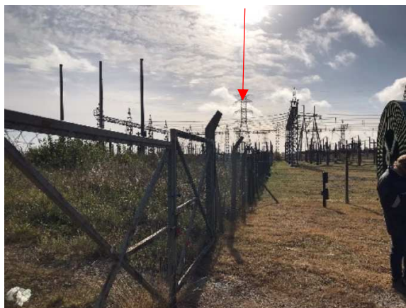
Foto 16. Desde el cerco perimetral señalado en foto anterior, observando en sentido NE, hacia el área operativa del banco de capacitores shunt a ejecutar. Se señala la torre indicada en la foto anterior.
