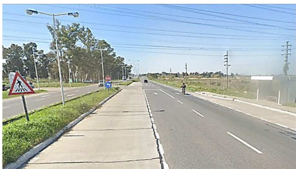
Imagen 9: Se observa – sobre RN N° 3 - la dársena de acceso a la ET EZEIZA viniendo desde el Sur. Sobre la derecha de la imagen se visualiza el refugio - parada de colectivos; sobre la izquierda de la imagen la advertencia de tránsito de peatones.
