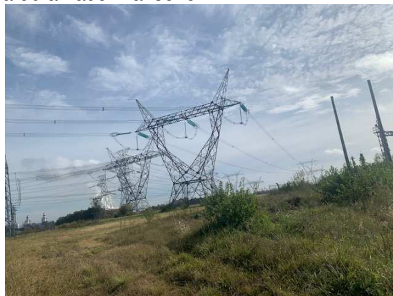
Foto 14. Se observan las dos torres reticuladas de las LEAT GRODRIGUEZ EZEIZA 500 1 y 2, que se encuentran localizadas dentro del predio de la ET EZEIZA, y que se ubican al NO del predio de la obra a ejecutar en el área operativa Lado Transener.
