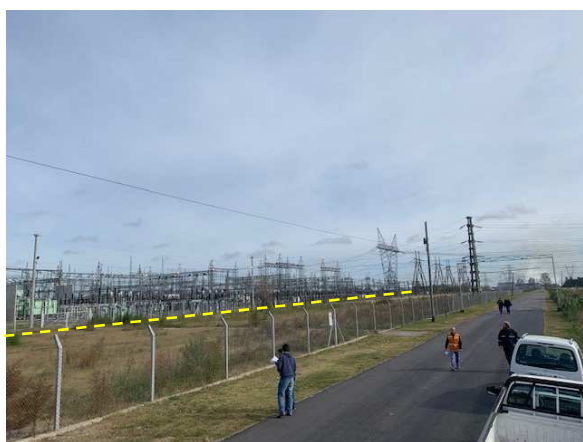
Foto 11: Tomada, en sentido NO, sobre la calle de acceso a la Central GENELBA; se visualiza la franja libre de terreno por donde se implantarán las dos ternas subterráneas y la fibra óptica (línea punteada). Al fondo, el predio de la obra Lado Transener. Se indica la traza de las LAT y FO
