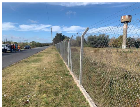
Foto 12. Tomada en sentido SE, sobre la calle de acceso a la Central GENELBA, a la altura de la obra de EDESUR, en el sitio donde se ejecutará el portón de acceso al predio. Se visualiza el tanque de la foto 9
